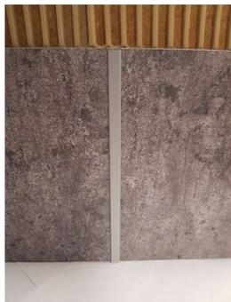
Profilé de liaison à utiliser pour la pose des panneaux Vipanel
