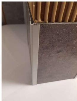
Profilé d'angle extérieur 90DEG pour finition panneaux muraux H3000mm
