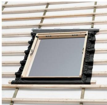
La collerette d'étanchéité (réf, BFX) assure l'étanchéité entre la fenêtre de toit et l'écran de sous-toiture en place. Un renvoi d'eau placé au-dessus de la fenêtre évacue les eaux de ruissellement de la sous-toiture.
