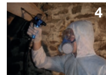
5 Pulvérisation du produit de traitement de bois D'XYL sur l'intégralité de la charpente
