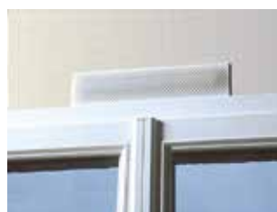
Clipser la grille intérieure de façon à masquer le passage d'air.
