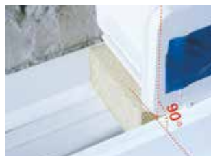
Positionner l'entrée d'air en respectant la verticalité...
