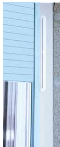
Dans ce cas de figure, prendre la précaution de placer le rail de volet de façon à ne pas obstruer la prise d'air extérieure.
