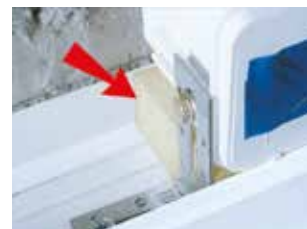
La mousse d'étanchéité évite pont acoustique et thermique.
