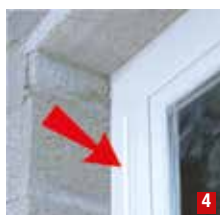
Le processus est le même que pour la pose à l'horizontale. Seule la mortaise doit être prévue différemment.
