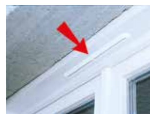
Mettre en place le cache extérieur. Etancher sous la collerette au mastic souple.
