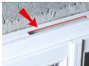
La mortaise est réalisée avant la pose de la menuiserie
