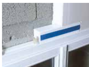
Pose du doublage
