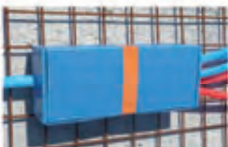
Mise en place sur treillis soudé
