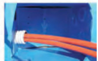
Passage des tubes PER dans la gaine (garantie biennale).
